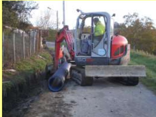
Pose de la canalisation d'eau pluviale sur la route du village
