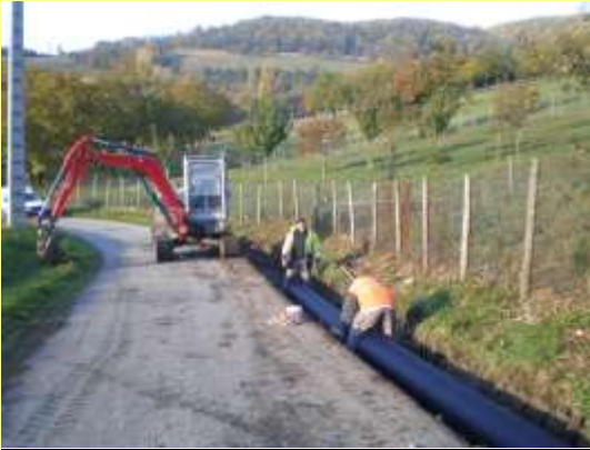
Pose de la canalisation d'eau pluviale sur la route du village
