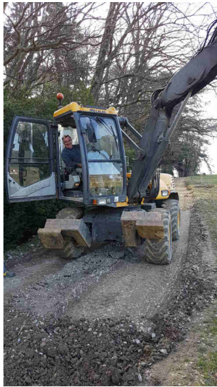
Empierrement entre l'extrémité du chemin du Mouret et la limite de St Appolinard.
